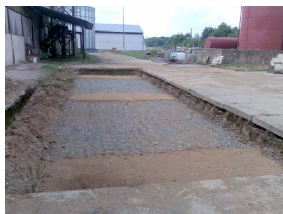
Obr.: Příprava lože pro prefabrikovaný základ 14-95 (úrovňová instalace)
