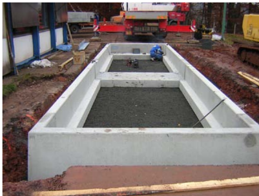
Obr.: Osazený prefabrikovaný základ 14-95
