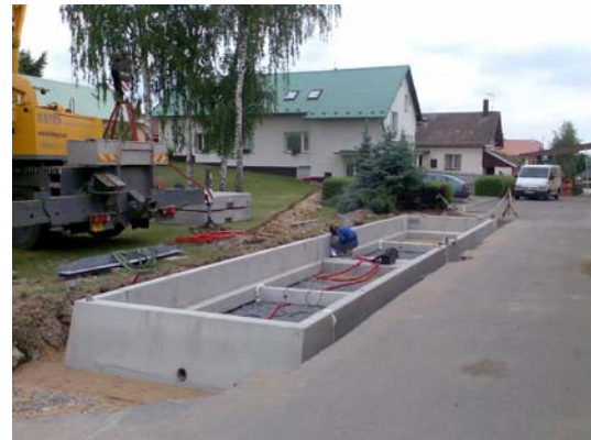
Obr.: Osazený prefabrikovaný základ 14-95
