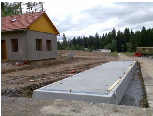
Obr.: Osazený most v prefa základu před dokončením navazujících komunikací
