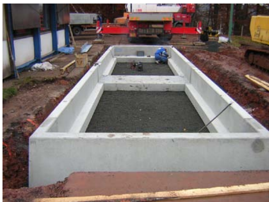
Obr.: Osazený prefabrikovaný základ 14-95
