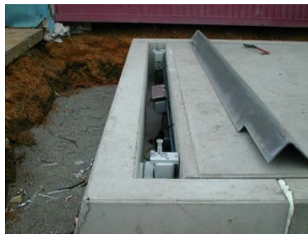
Obr.: Detail uložení snímačů zatížení a jejich zakrytí
