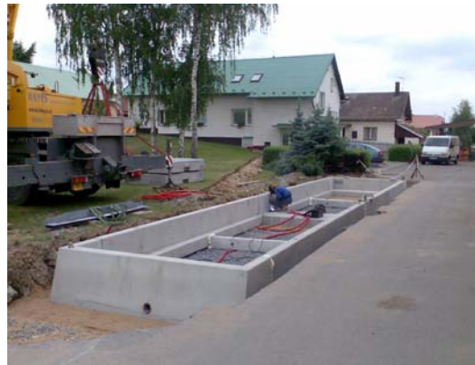
Obr.: Osazený prefabrikovaný základ 14-95
