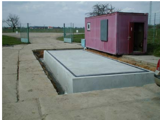
Obr.: Osazený most v prefa základu před dokončením navazujících komunikací
