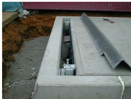
Obr.: Detail uložení snímačů zatížení a jejich zakrytí
