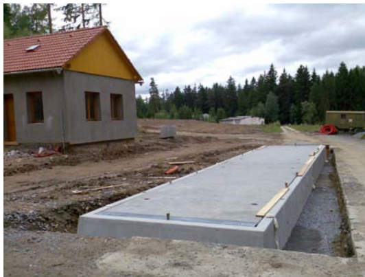
Obr.: Osazený most v prefa základu před dokončením navazujících komunikací
