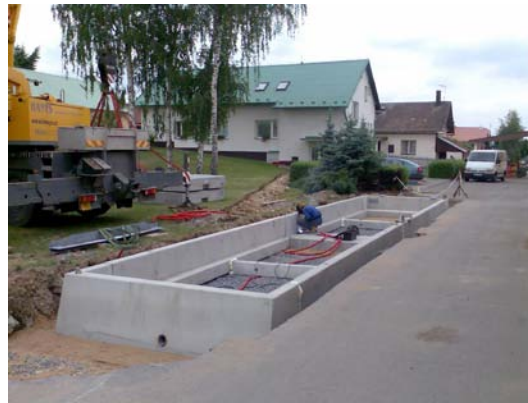
Obr.: Osazený prefabrikovaný základ 14-95
