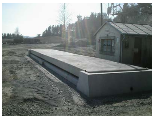
Obr.: Prefabrikovaný základ a most (před zhotovením nájezdových komunikací)
