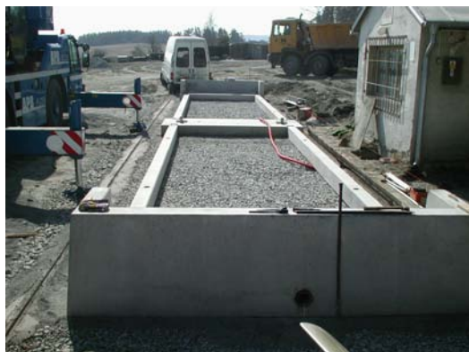
Obr.: Prefabrikovaný základ a most (před zhotovením nájezdových komunikací)
