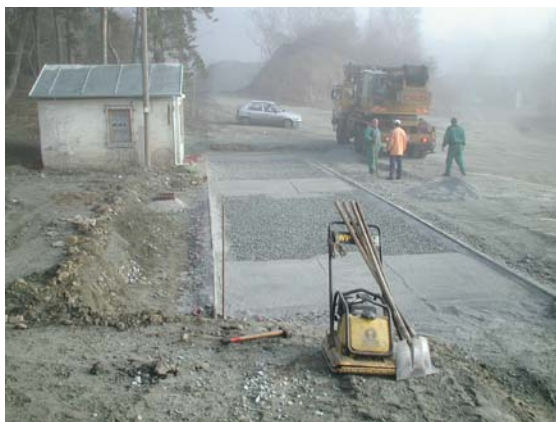
Obr. Příprava lože - prefabrikovaný základ 14-93 (nájezdová instalace)
