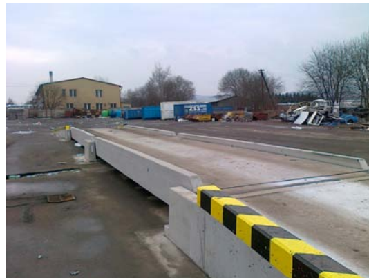
Obr.: nájezdová silniční váha s nájezdy a dokončenými terénními úpravami
