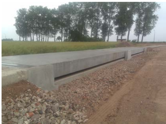
Obr.: nájezdová silniční váha s nájezdy a dokončenými terénními úpravami
