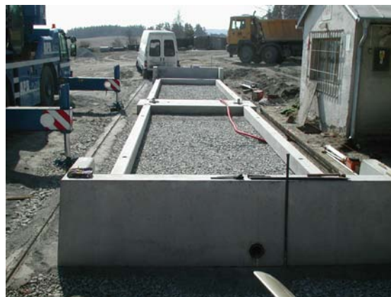
Obr. Příprava lože - prefabrikovaný základ 14-93 (nájezdová instalace)
