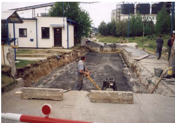
Obr.: Příprava lože pro prefabrikovaný základ 14-95 (úrovňová instalace)
