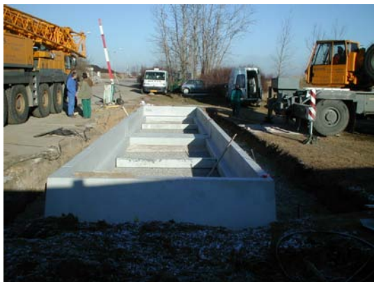
Obr.: Osazený prefabrikovaný základ 14-95 (pro váhu 18m)
