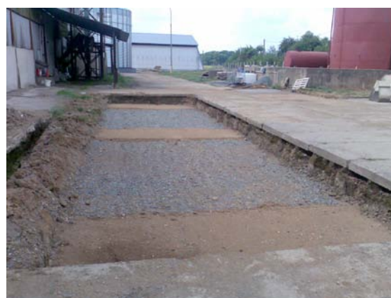
Obr.: Příprava lože pro prefabrikovaný základ 14-95 (úrovňová instalace)
