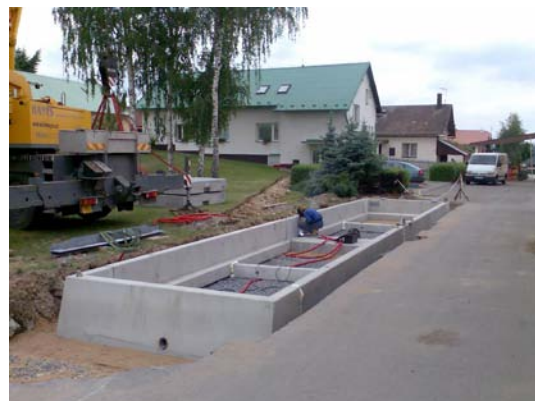
Obr.: Osazený prefabrikovaný základ 14-95 (pro váhu 18m)
