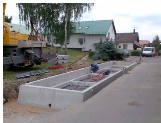
Obr.: Osazený prefabrikovaný základ 14-95
