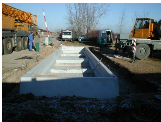
Obr.: Osazený prefabrikovaný základ 14-95
